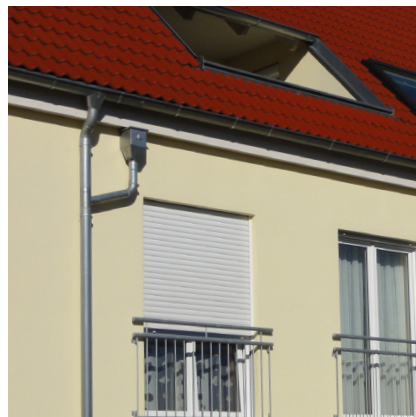
Uporaba za odtočne vertikalne žlebove
