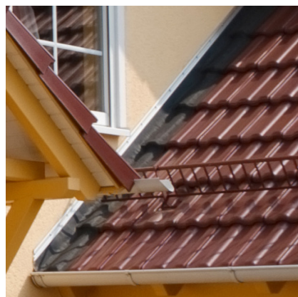
Uporaba pri zaključne ploščevine
