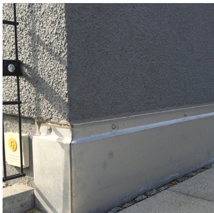
Montiran IPSD-H pritrjen s kleparskimi vijaki
