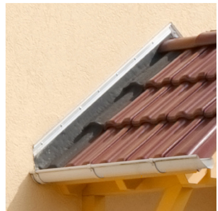
Uporaba pri zaključne pločevine
