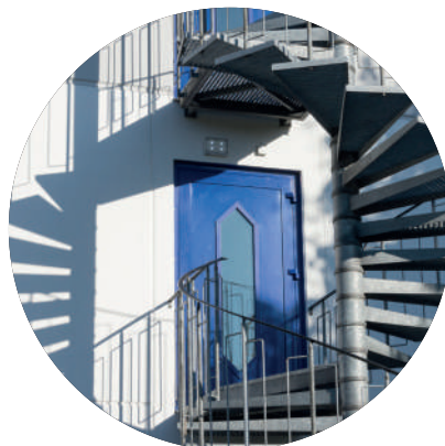
Befestigung von Geländern
