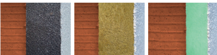
Beispiel: Hochlochziegel, Styropor, Putz
