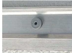
**Isolierplattenschraube IPS 80**
