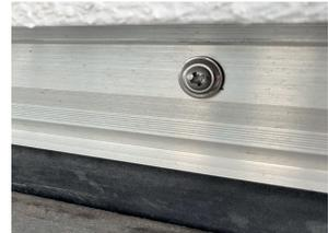
**Isolierplattenschraubdübel IPSD 80**
